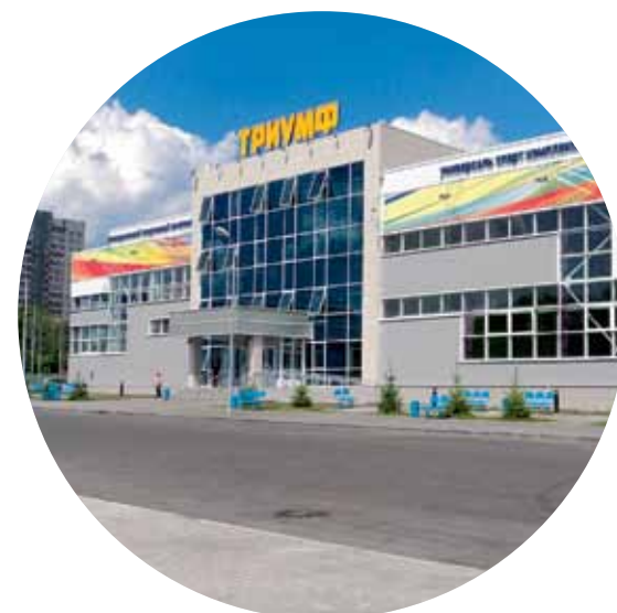
В спортивный комплекс «Триумф» (в строительстве применялся материал ROCKWOOL РУФ БАТТС) входят крытая ледовая арена, игровой зал и бассейн. Во время Универсиады здесь пройдут тренировки баскетболистов
