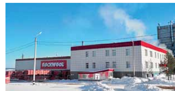
Здание завода ROCKWOOL в Троицке – до (на фото сверху) и после реконструкции с применением теплоизоляционных плит ВЕНТИ БАТТС Д
